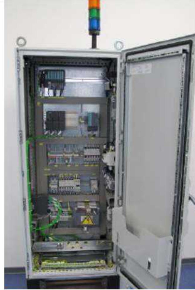
Dolap, kablolama, montaj
